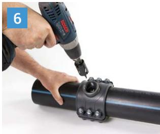
**Forare il tubo con un trapano dotato di apposita punta a tazza facendo attenzione a non danneggiare i filetti della staffa.**
